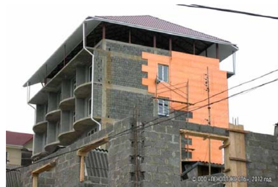
Một số hình ảnh PENOPLEKS trên công trình đang thi công
